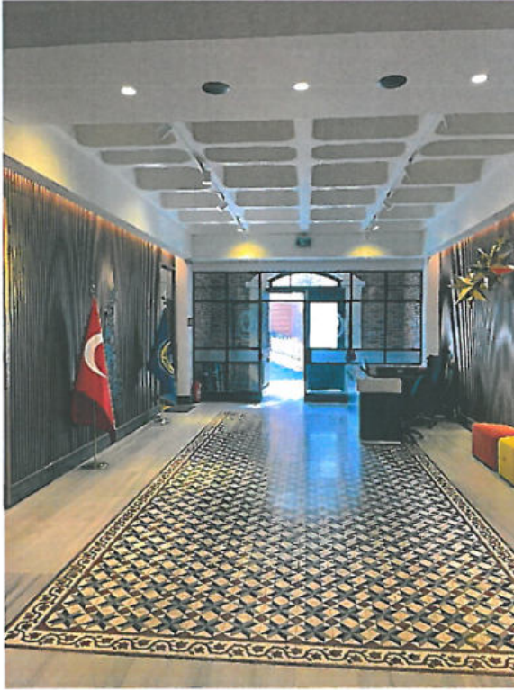
Foto 7. Kiriş ve Kaset döşeme, A blok girişi, binanın kirişler ile çevre perde duvar bağlantısı.
